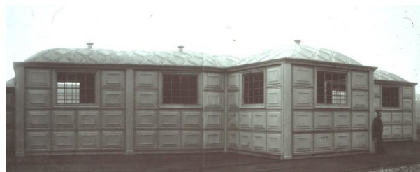
Baraque hôpital Danly sans ossature, 1885
